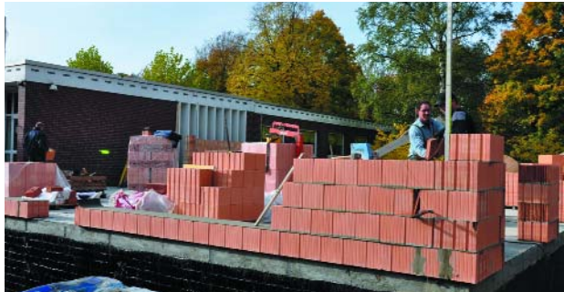
Die ersten Steine werden auf das Fundament gesetzt.
