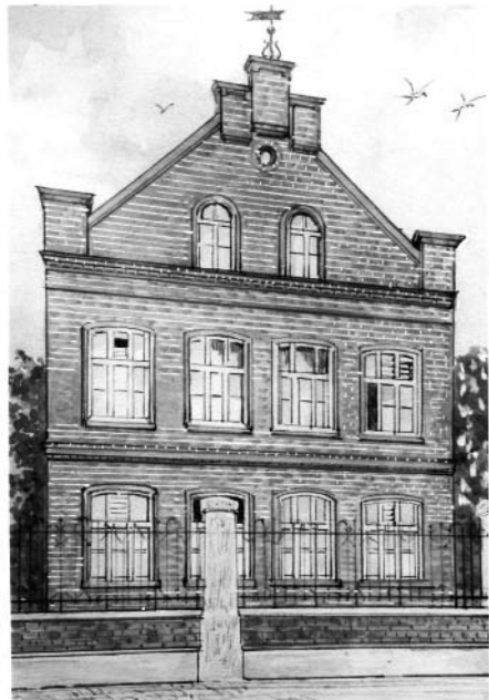
Das Schulgebäude am Nordwall 14
