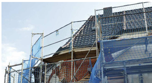
An einigen Stellen waren die Schäden am alten Putz größer als zunächst erwartet – beispielsweise am Chorraum.
